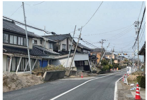
内灘町内の液状化現象の現場
