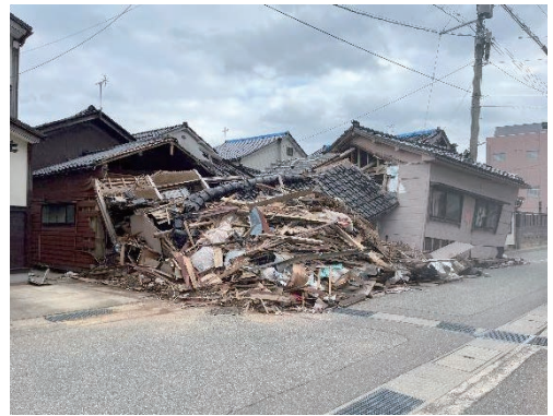
輪島市内の倒壊した民家
