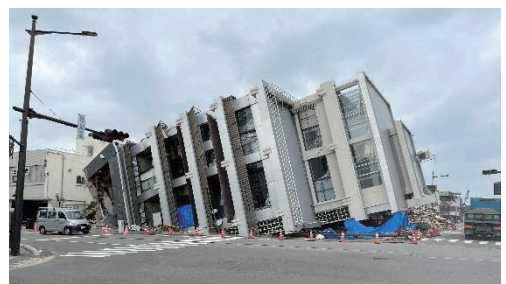
輪島市内のビル倒壊現場
